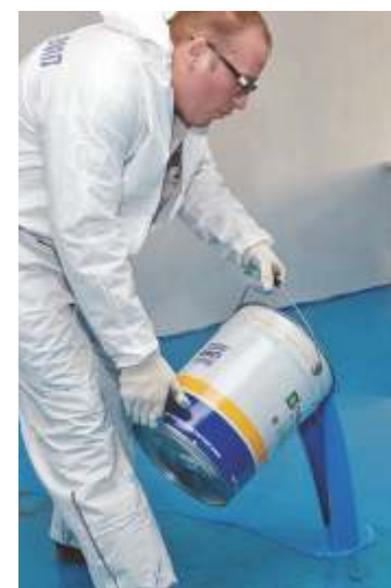
聚合物浇筑地板配套工程
